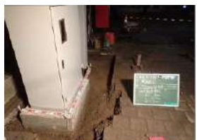
設置工事（収納箱）
