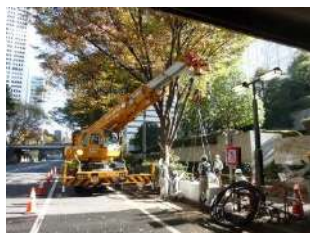
設置工事（基礎）
