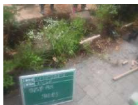
植栽帯防護柵撤去
