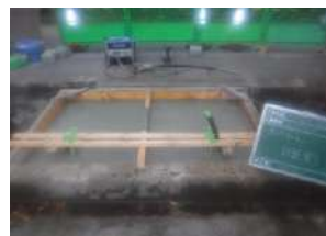
基礎工事（生コン打設）
