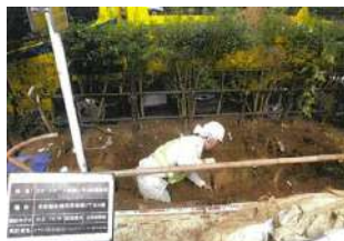
試掘調査（手掘り）
