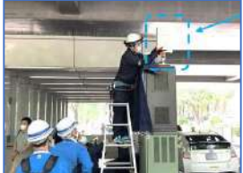
電源敷設工事
