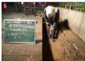
光回線敷設工事
