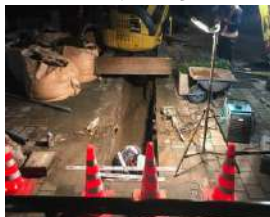
光回線敷設工事
