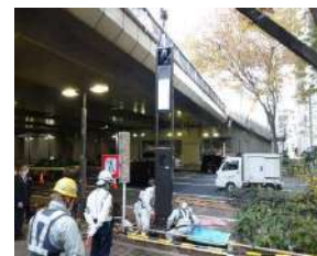
設置工事（躯体）
