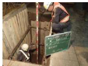
基礎工事（掘削）
