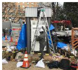
設置工事（建柱）
