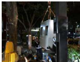
設置工事（収納箱）
