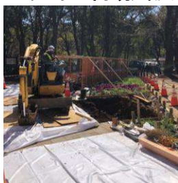
基礎工事（掘削）
