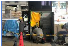
電源敷設工事
