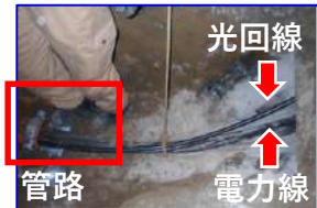
光回線敷設工事
