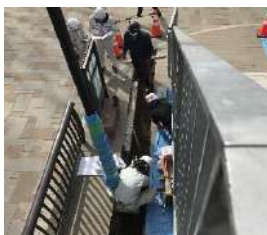
電源敷設工事
