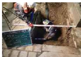
基礎工事（掘削）
